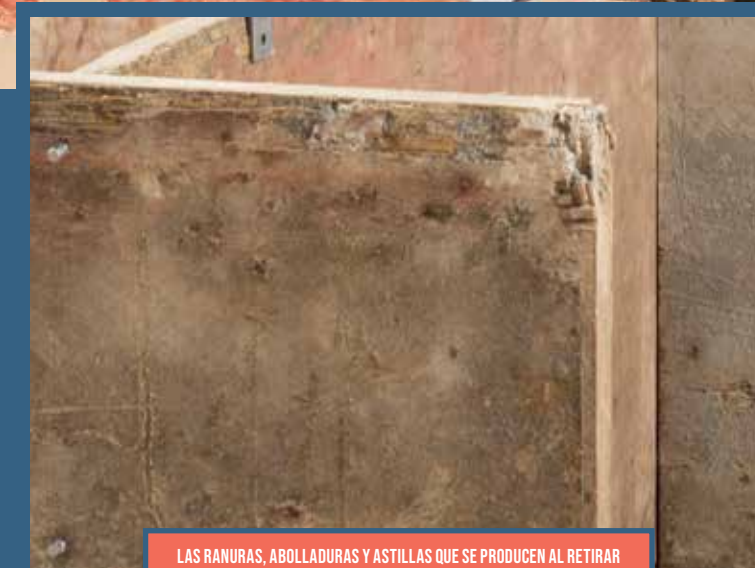
LAS RANURAS, ABOLLADURAS Y ASTILLAS QUE SE PRODUCEN AL RETIRAR CLIPS DE ENCOFRADOS CONVENCIONALES ARRUIAN ENCOFRADOS COSTOSOS
