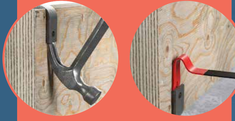
LAS RANURAS, ABOLLADURAS Y ASTILLAS QUE SE PRODUCEN AL RETIRAR CLIPS DE ENCOFRADOS CONVENCIONALES ARRUIAN ENCOFRADOS COSTOSOS
